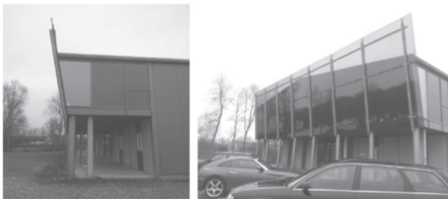
Figura 2. Nave industrial para emplazamiento del proyecto
